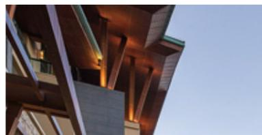
投光照明手法，仅强化屋檐局部构造，灯光精简而有力，强调中式建筑的独特造型。
